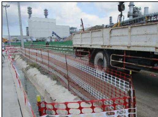
รูปที่ 2-14 รางระบายและรางรวบรวมน้ำฝนชั่วคราว
