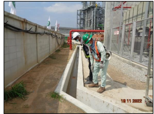
รูปที่ 2-16 เจ้าหน้าที่คอยตรวจสอบระบบระบายน้ำชั่วคราว
