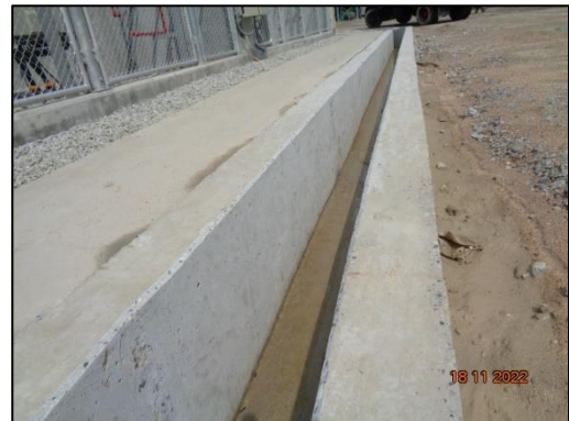
รูปที่ 2-14 รางระบายและรางรวบรวมน้ำฝนชั่วคราว
